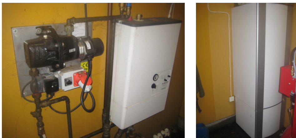
Figur 3-4: Elpanna och varmvattenberedare för uppvärmning av vatten med el.
