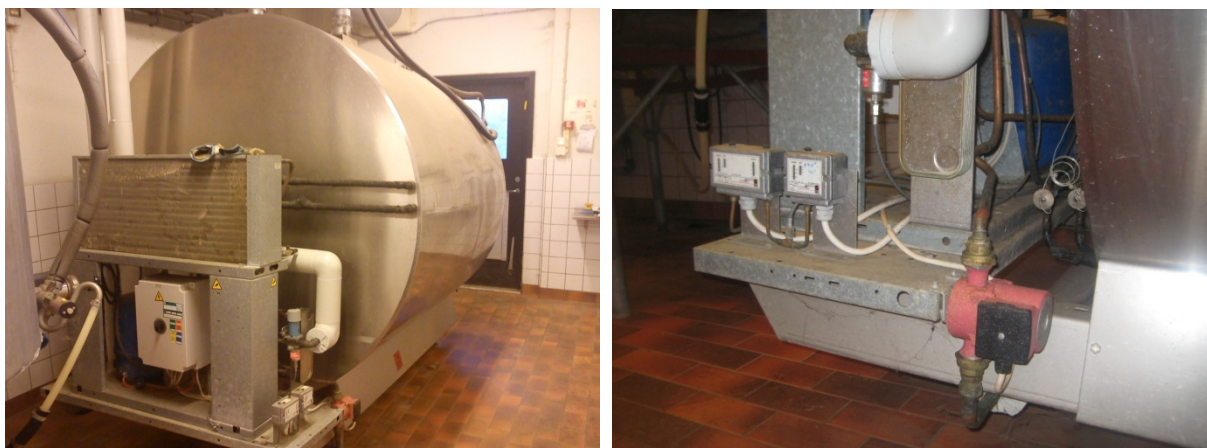
Figur 3-13: Mjölkkyltank från Wedholms med hetgasvärmväxlare.
