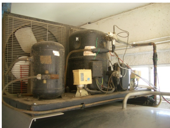
Figur 3-9: Mjölkkyltankens kylsystem utan värmeåtervinning.
