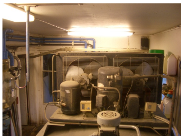
Figur 3-9: Mjölkkyltankens kylsystem utan värmeåtervinning.
