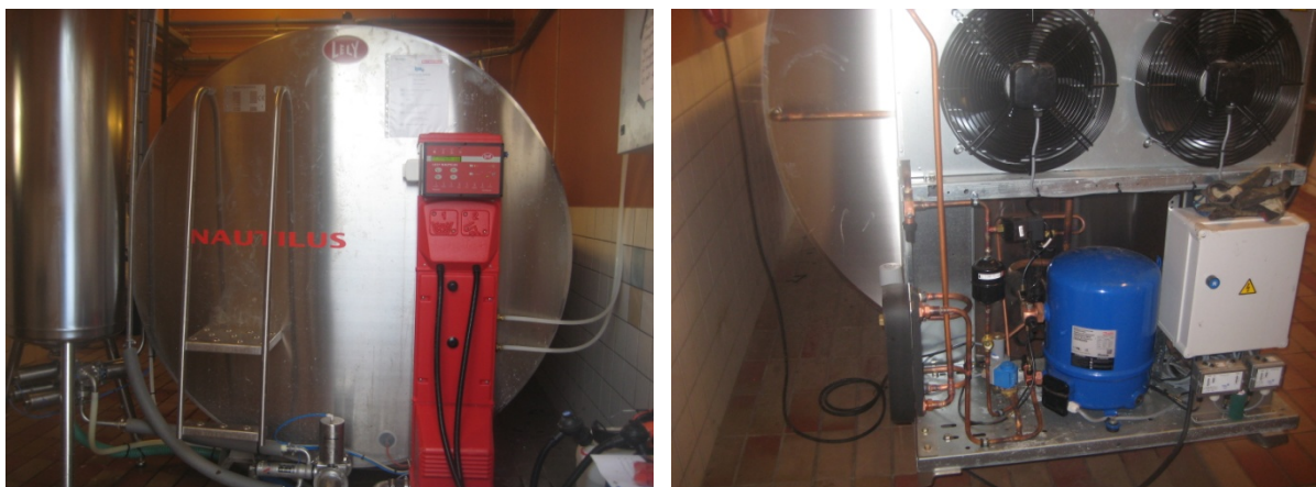
Figur 3-2: Mjölkkyltanken på gård #1 med tillhörande kylsystem.
